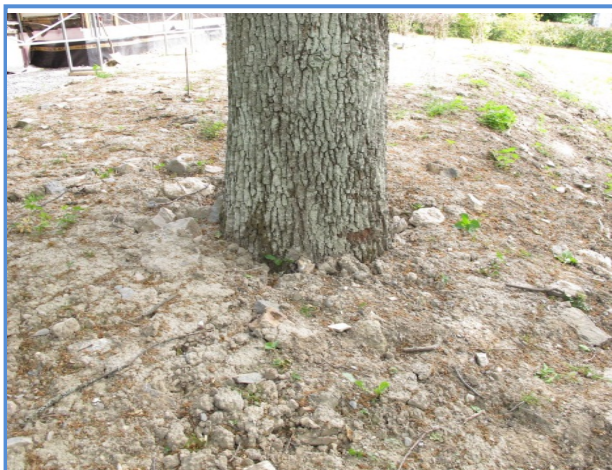
Figur 5. Pålegging av fyllmasse rundt eik i hage i Drøbak. Foto: Stefan Olberg.
