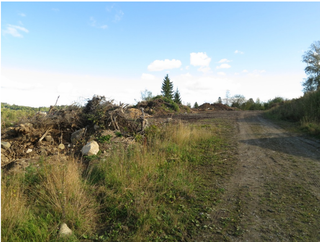
En anleggsvei går igjennom området og det er henlagt noe fyllmasser i området.
