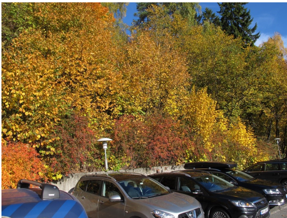
Figur 4. Hageplanter stående på toppen av mur mellom parkeringsplass og Lilleåsen. Foto: Stefan Olberg.
