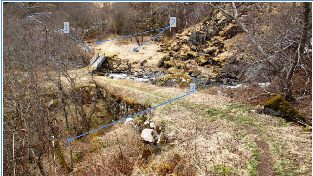
Kongeveien ved Soknefossen. Pilene på bildet angir: 1 – En liten gråor med Rinodina stictica som står tett inntil brufundament og derfor kan være nødvendig å fjerne. 2 – Åpne areal påvirket av fosseyr fra Soknefossen som på sikt bør få gro igjen med gråor. 3 – Skråning nedenfor Kongeveien hvor noen trær er nødvendige å fjerne i forbindelse med restaureringsarbeidet. Foto: Jon T. Klepsland, 6. mai 2013.
