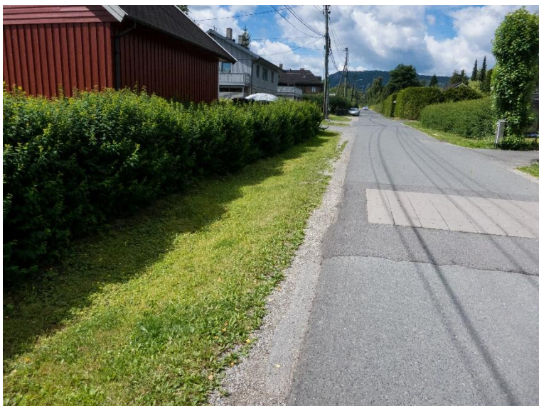
Figur 3: Den østre delen av undersøkelsesområdet er til en stor grad bebygd langs vegen.
