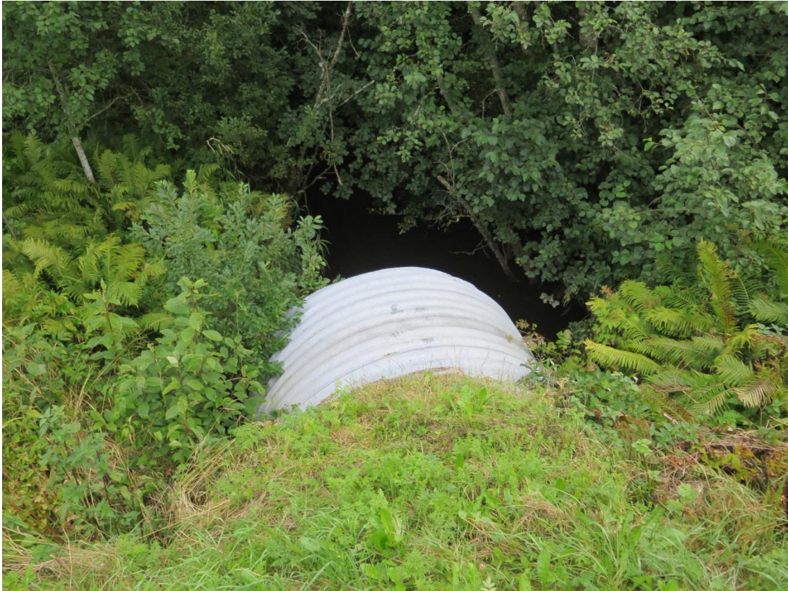
Figur 4. Damholbekken går i en kulvert under Svenskerudveien. Foto: Ole J. Lønnve.
