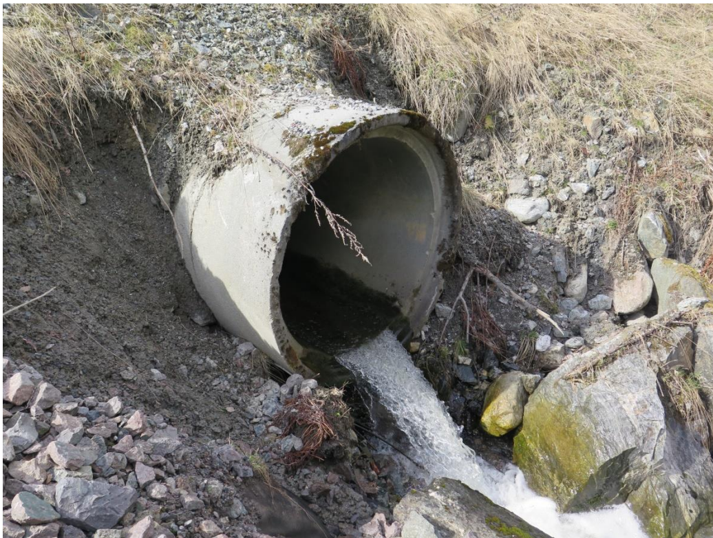
Figur 6. Kulverten under veien til Søndre Harstad representerer et vandringshinder for eventuell fisk. Foto: Ole J. Lønnve.
