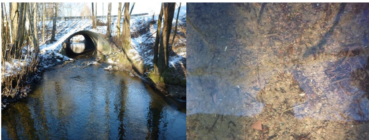
Figur 6: Bildene 3 og 4 (figur 4). Neselva nedenfor kulverten under Bergerveien. Kulverten er godt konstruert for fiskevandring med en del grus og stein i bunn. I bilde 4 til høyre ser man at bunnsedimentene ca 30 m nedenfor kulverten har mer organiske rester og begynner å bli mindre i størrelse, er mer homogene og med tegn til finpartikler/slam. Foto N.L. Colman, 23. februar 2016.
