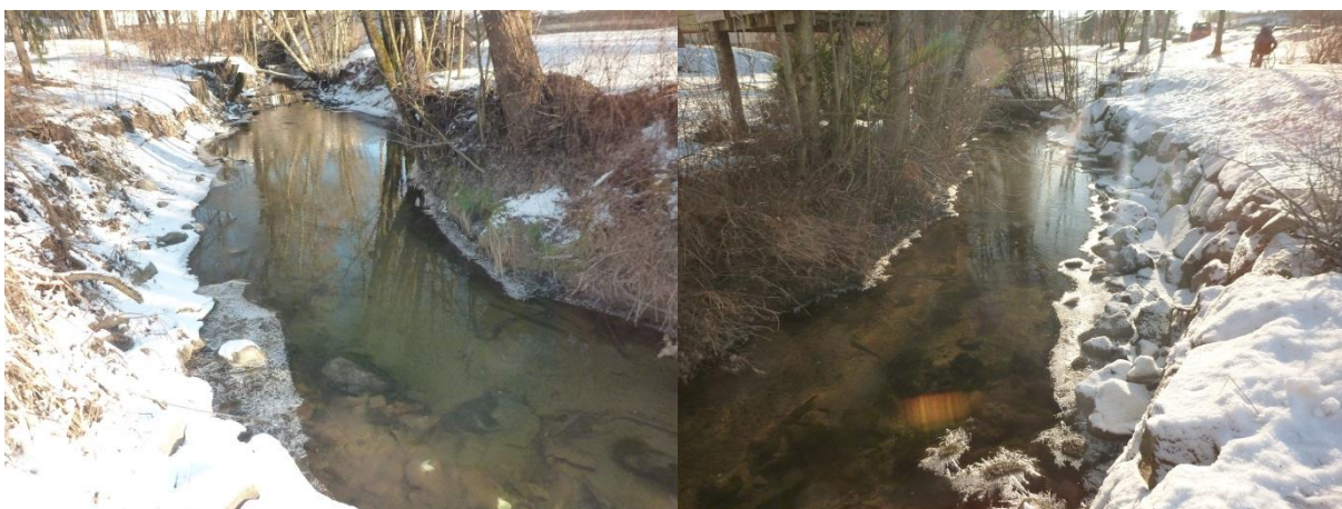
Figur 8: Bildene 7 og 8 (figur 4). Den delen av tiltaksområdet langs Neselva med minst kantsoner. Det er også herfra og ned til Billingstadsletta det kan bli størst påvirkninger. Den ene siden går langs to private hager og den andre langs gangstien med steinsetting/forbygging på siden med gangstien i bilde 8 til høyre. Litt dypere og rolig strekning. Bunnforhold er mest sand og spredt større steiner og død ved. Ikke gyteområde, men fine oppvekstområder. Foto N.L. Colman, 23. februar 2016.
