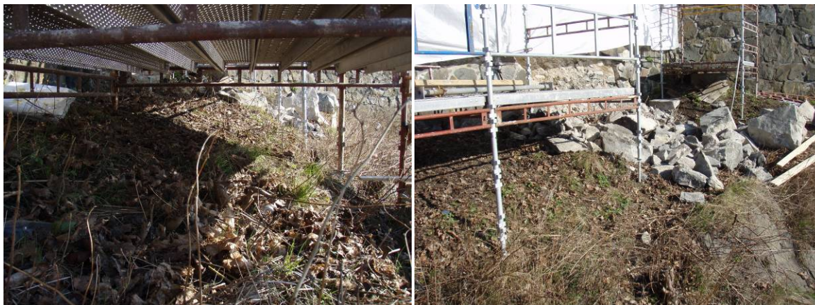
Figur 34. Stillasene som ble benyttet under rehabiliteringen av festningsmuren i 2008 ble bygget opp fra bakken, noe som ga levelige forhold for faunaen på stedet også under byggearbeidene (men deler av arealet ble brukt til mellomlagring av steiner).
