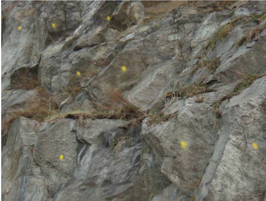
Figur 32. I nordre del av området er rassikringsarbeidet pr. 25. november 2008 ikke fullført. En stor mengde gule markeringer tyder på at det også skal settes inn sikringer i dette området.
