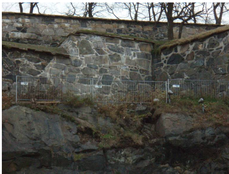
Figur 35. Anleggsstedet ved lokalitet Akershus festning VI pr. 25.11.2008 (sammenlikn med Figur 21).
