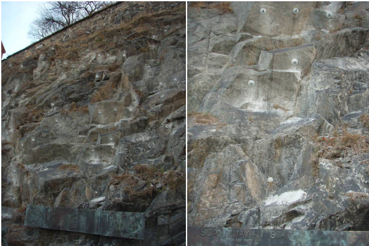
Figur 30. Store deler av bergveggene vest for Akershus festning ble i 2008 sikret mot utrasinger.
