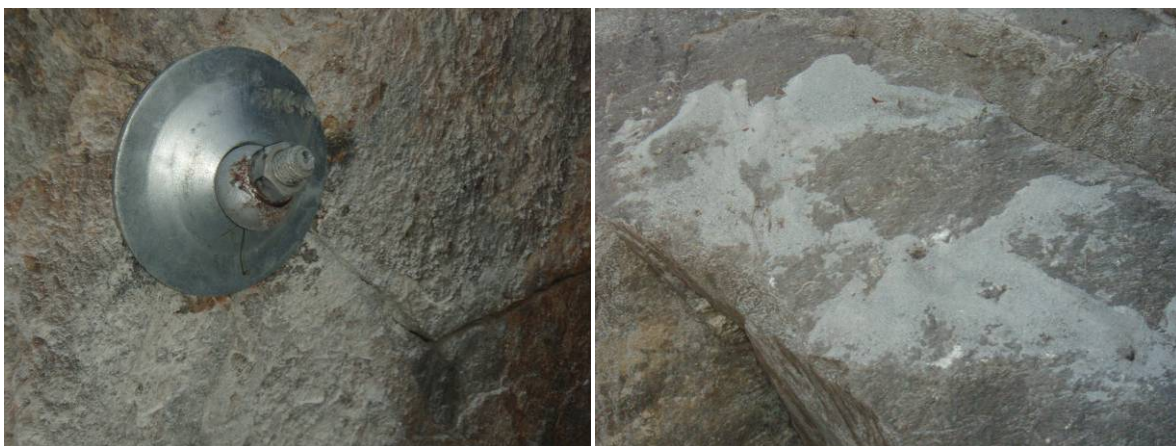
Figur 31. Boring av huller i bergveggene for feste av sikringer (til venstre) etterlater seg en stor mengde borestøv nedover i fjellsiden (til høyre, se også Figur 30)
