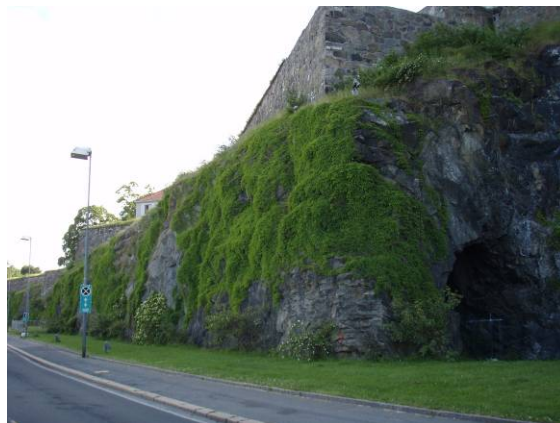
Figur 27. Akershus festning III i 2007, utsiden av nordre tunnel. Sammenlikn med Figur 18.
