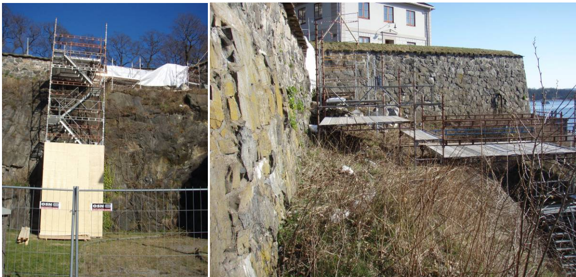
Figur 33. Installasjoner i forbindelse med reparasjoner på festningsmuren i 2008. Området på det høyre bildet utgjør Akershus festning VI.
