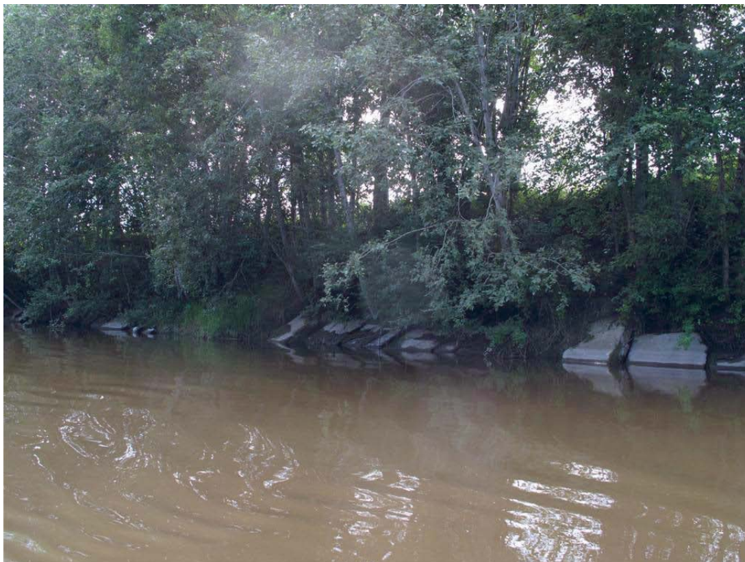
Figur 9: Forbygninger finnes flere steder over lengre strekninger. Her er betongelementer langt ut for å hindre elva i å grave i yttersving.
