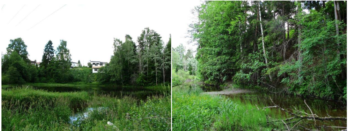
Venstre: Svensedammen. Høyre: Flomdam ved innløpet til Svensedammen.
