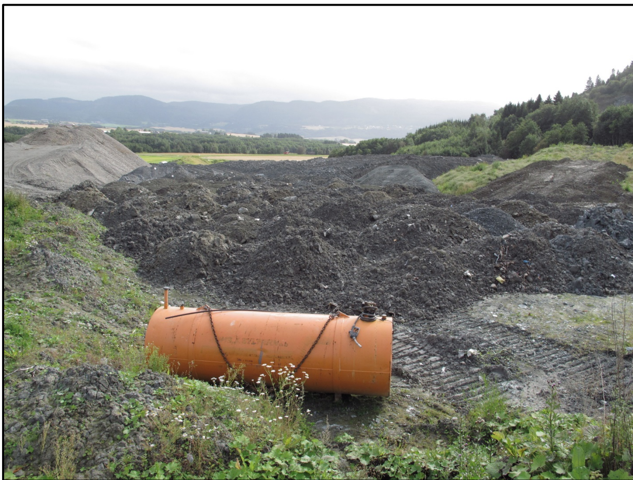
Areal på østsiden av Fv 735 ved Reitan-Udduvollen i Melhus som allerede er tatt i bruk som deponiområde for løsmasser. Foto: Jon T. Klepsland, BioFokus.
