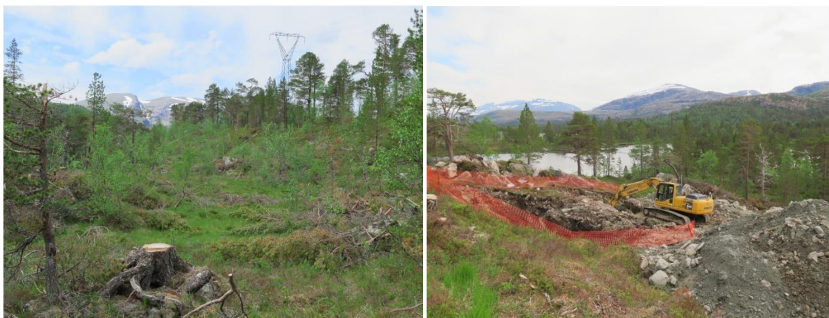
Bygging av ny kraftlinje gjennom Myklebustdalen. Foto: Tom H. Hofton 2014.
