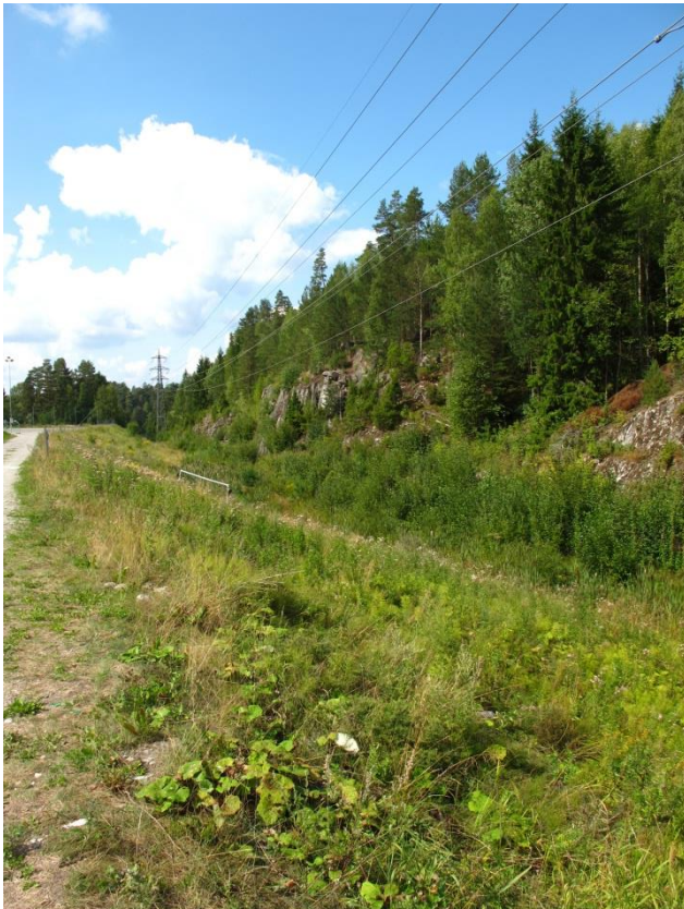
Figur 12. Biologisk uinteressant område under høyspentlinjen.
