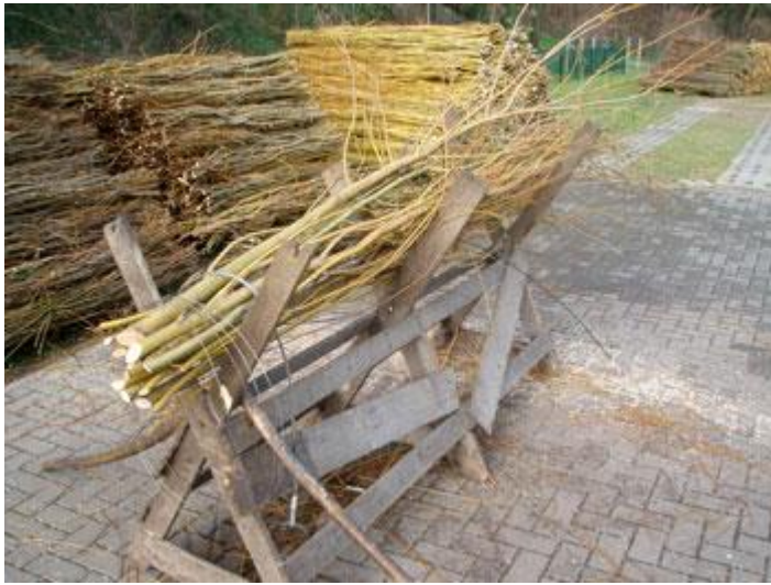
Figur 16. Faskiner lages ved å binde sammen kvister av f. eks. vier. Fasiner virker mot bekkekantererosjon og bremser strømning. Ved bruk av levende vierkvister vil de etterhvert lage skudd og etablere seg til busker med stabiliserende rotsystemer. (Foto fra http://www.wsa-magdeburg.de )
