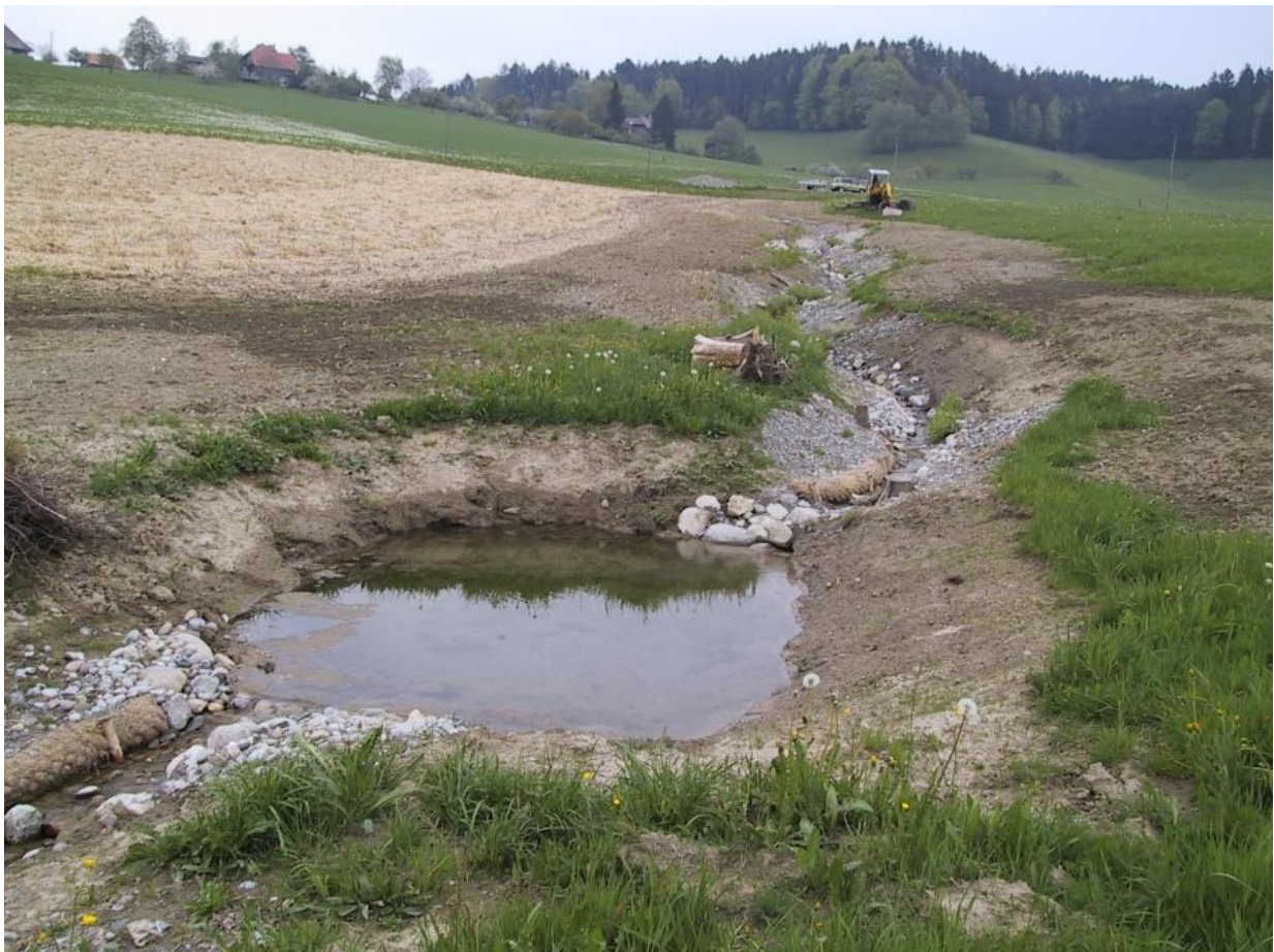
Figur 12. Eksempel på steinsetting av bekkeløp med kulp i et bekkeåpningsprosjekt. Overgangene er steinsatt. (Foto: Naturalengineering, Scheuter Consulting, Belp, Sveits).
