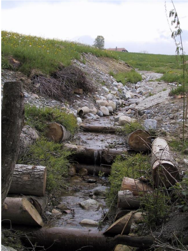
Figur 18. Eksempel på bruk av temporære biologiske løsninger med dødt materiale som overtas av levende materiale: Temporær vannterskel av tømmer-materiale Oppslag av vierarter viser på hvordan levende vegetasjon vil overta stabiliserings- og terskels-funksjonen i fremtida. (Foto: Naturalengineering, Scheuter Consulting, Belp, Sveits)
