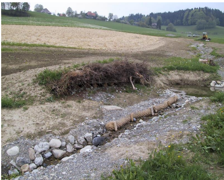
Figur 19. Eksempel på hvordan ingeniørbiologiske løsninger kan brukes for erosjonssikring: Ved bekkeåpning i Mittelhäusern, Sveits, ble det brukt ruller av kokosmatter som temporært tiltak mot erosjon. I tillegg ble det bygget et gjemmested for forskjellige smådyr av grantømmer dekket med kvister og jord. (Foto: Naturalengineering, Scheuter Consulting, Belp, Sveits)
