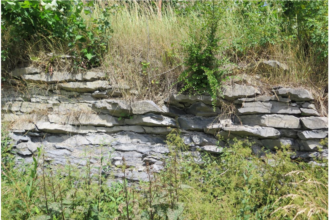
Figur 5: Sørvendt veiskjæring langs Fjordgata. Skjæringen utgjøres av lagvis skifer, der det mellom skiferlagene finnes porøs sandholdig jord. På sensommeren ble det registrert stor aktivitet av enkelte bier i tilknytning til denne skjæringen, og det ble observert mange huller etter bier mellom skiferlagene. Metalljordbien Lasioglossum morio var den dominerende biearten, men også enkelte andre bier og sandtilknyttede veps ble funnet. Foto: Ole J. Lønnve.
