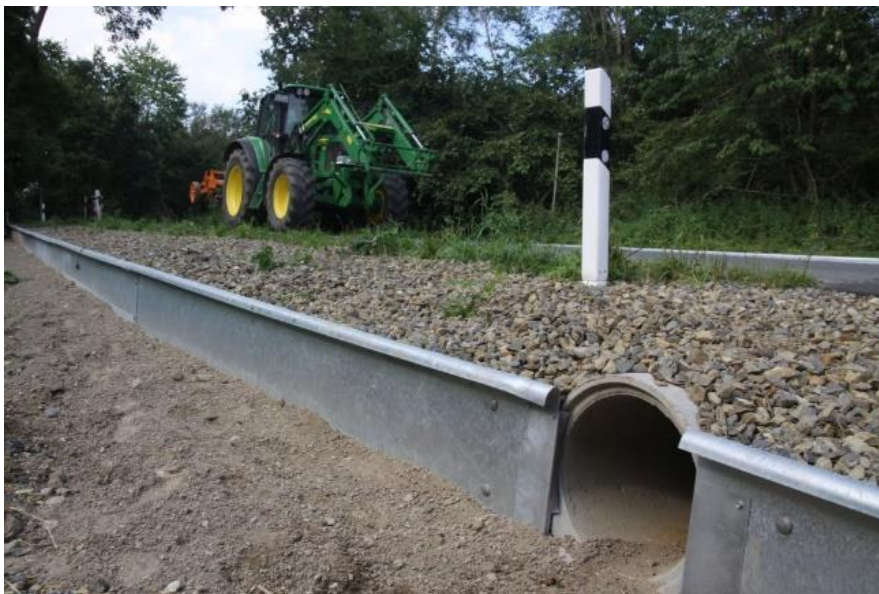
Figur 2: Eksempel på amfibierør med metallplater som leder amfibiene til røret. Røret er 40 cm i diameter. ( http://www.nw.de/lokal/kreis_herford/buende/buende/20546944_Sicheres-Geleit-fuer-Kroeten.html )
