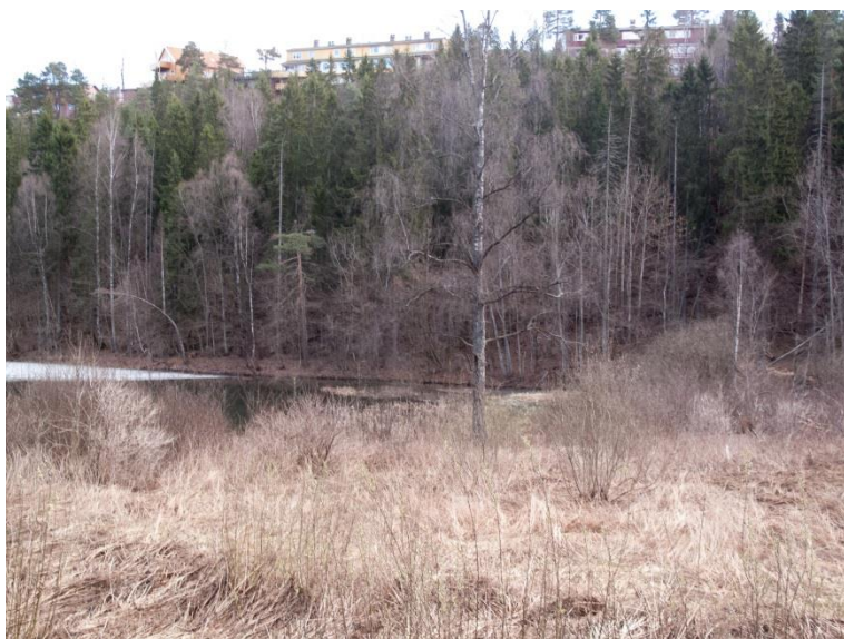
Figur 5: De indre deler av dammen sett mot sør.
