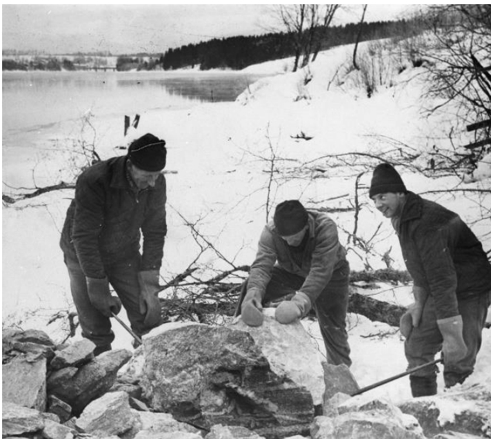
Figur 6. Sikring av elvebredden langs Nestangen 1975.
