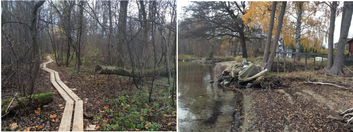
Figur 9. Venstre: Klopp skånsomt anlagt gjennom flommarksskogen ut til fugletårnet i Linnestranda naturreservat. Høyre: Steinfyllinger, betongmurer og utvidelse av private tomter helt ned i strandsonen. Foto: Anders Thylén.
