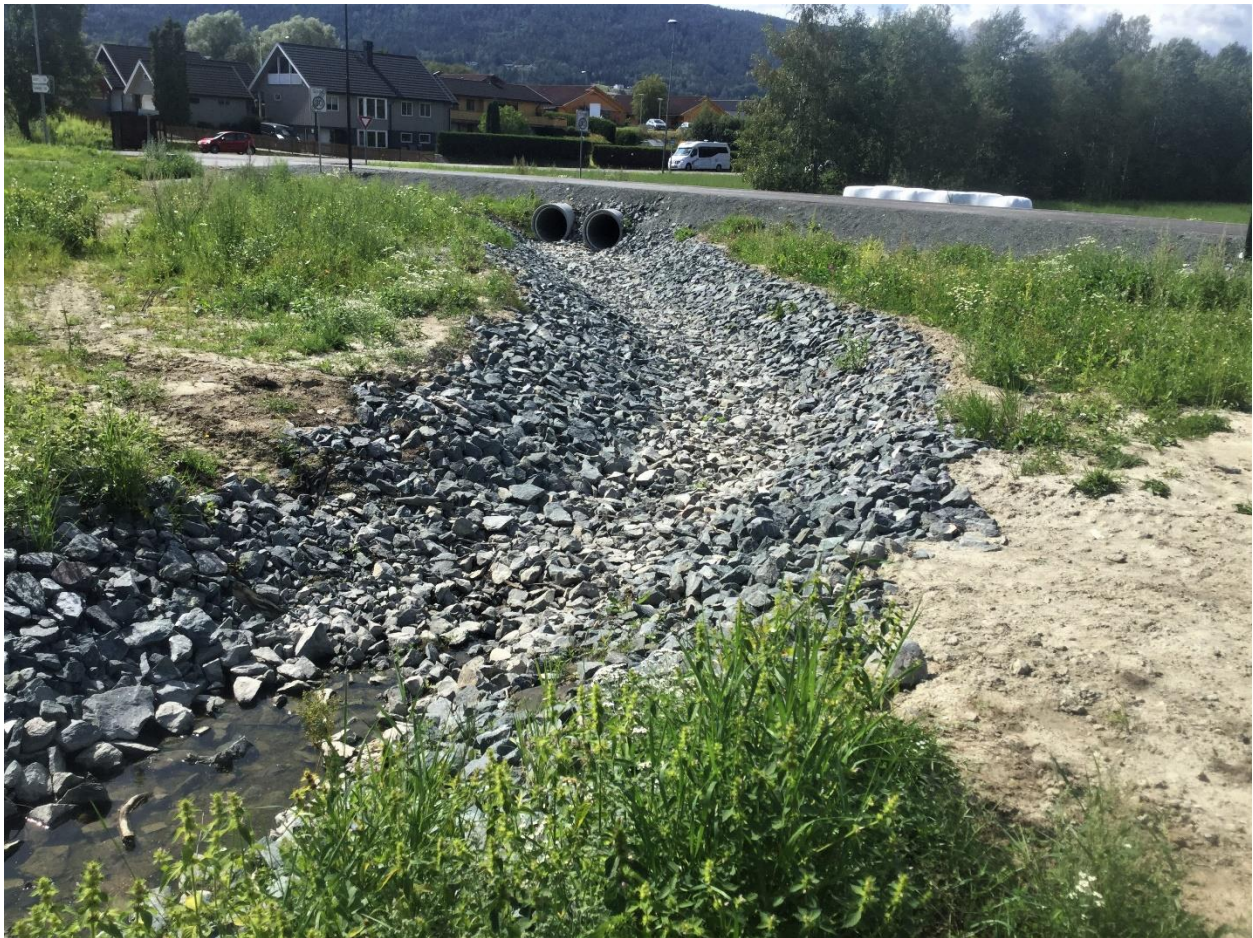
Figur 10: Flomsikring av den viktigste tilførselsbekken ved Klokarrudvegen har gjort at mye av vannet dreneres ned i grunnen før det når sumplokaliteten. Foto: Lars Erik Høitomt.
