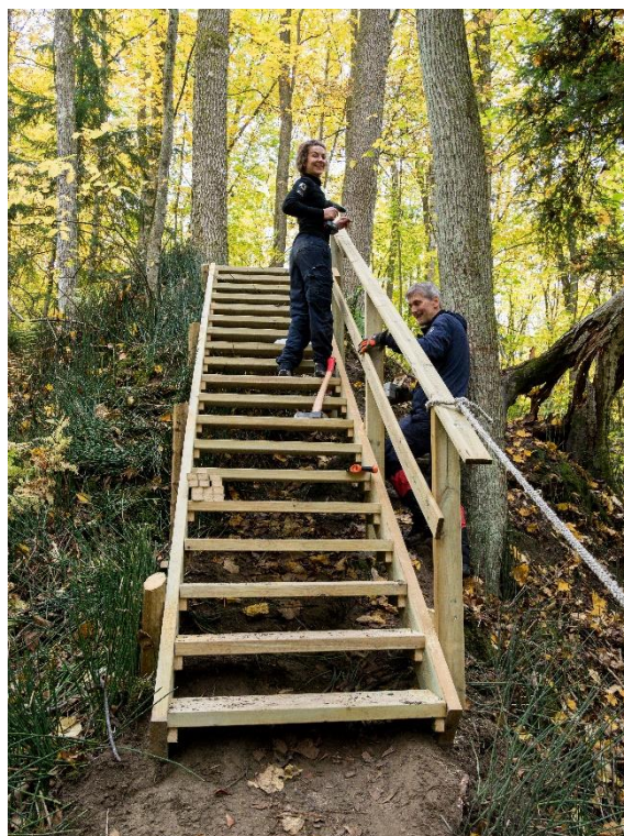
Figur 13. I bratte partier kan man vurdere å bygge klopper med tverrgående lister (t.v.) eller tretrapper (t.h.). Fotos: Kim Abel.
