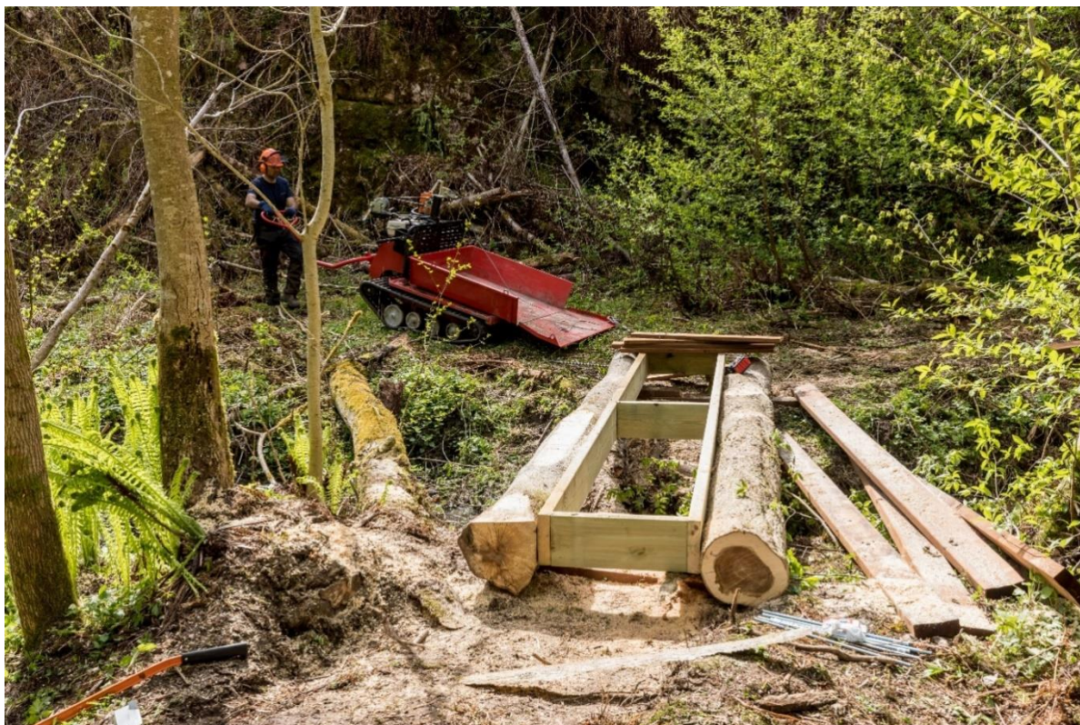
Figur 10. Bygging av enklere bru i Holtnesdalen naturreservat 2017. Foto: Kim Abel.
