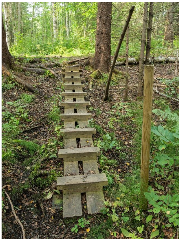
Figur 13. I bratte partier kan man vurdere å bygge klopper med tverrgående lister (t.v.) eller tretrapper (t.h.). Fotos: Kim Abel.
