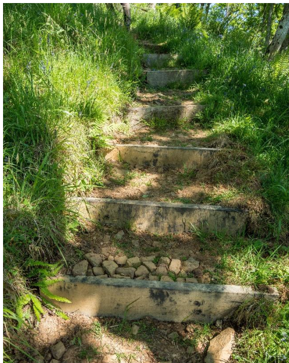
Figur 12. Eksempler på utforming av enkle trapper tilpasset terrenget. T.v. med tverrliggende stokker. Bildet t.v. er hentet fra Miljødirektoratets veileder om naturvennlig tilrettelegging. T.h. med tverrliggende steinplater. Foto: Kim Abel.
