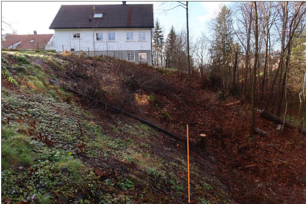
Figur 7: Tiltaksområdet der nytt hus er planlagt fra toppen av og et godt stykke ned i skråningen. Oransje linje viser omtrentlig grense for hvor langt ned i skråningen huset kommer.
