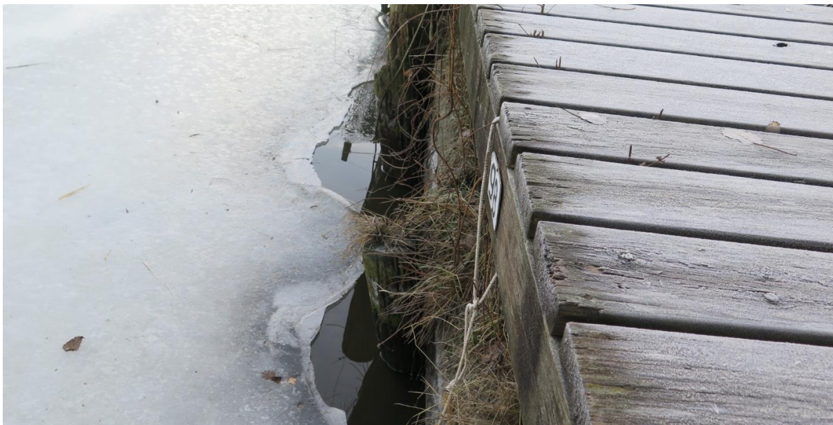
Figur 4: En brygge går langs elvebredden til Såna. Brygga hviler opp på en opparbeidet rett kant, og er støttet opp av pilarer langs denne kanten. Foto: Ole J. Lønnve.
