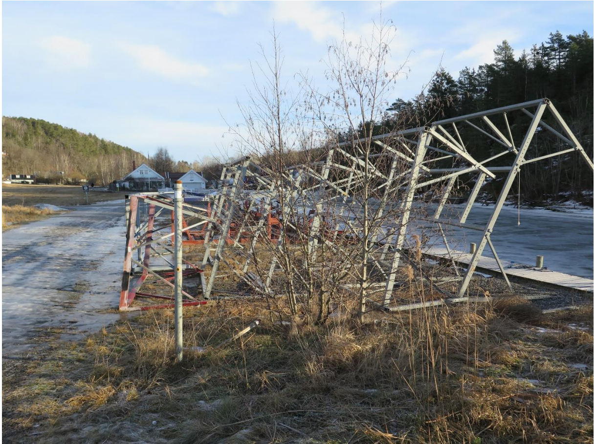
Figur 7: Parti fra kantsonen langs Såna mellom Elveveien 1 og Kolåsveien. Arealet er asfaltert, og her er ingen funksjonell kantsoner. Foto: Ole J. Lønnve.
