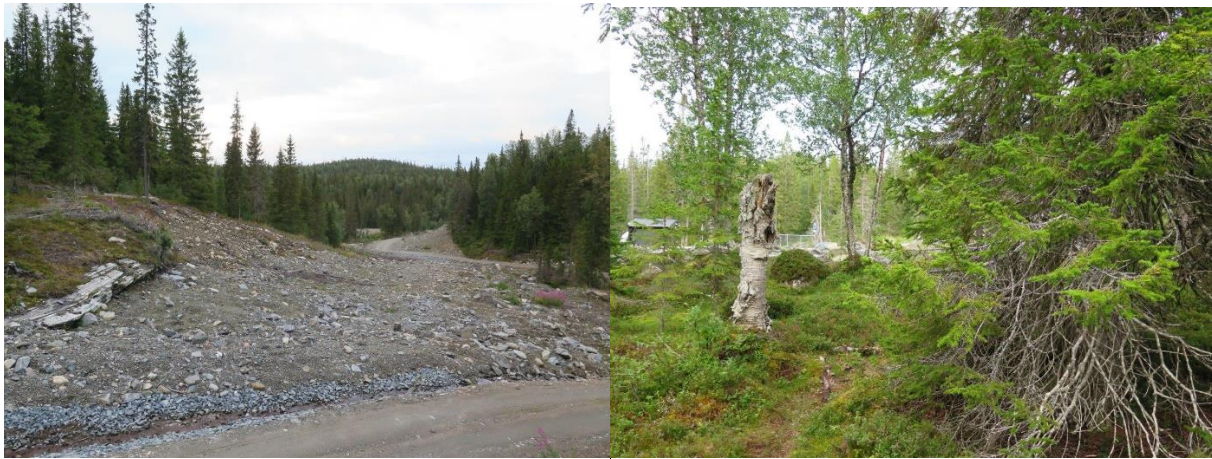
Figur 56 (v), 57 (h). Ulike utbyggingsformål utgjør lokalt trusler mot taigabendellav. I Fiskløyselva småkraftverk i Muru (Lierne) har veianlegg/rørgate (venstre) og inntaksdam-anlegget (høyre) lagt beslag på gammel gran-naturskog. Taigabendellav ble i 2021 påvist på eldgamle grantrær helt inntil begge sider av inntaksdam-anlegget (bl.a. på skjørtegrana til høyre, der inntaksdam-anlegget ses i bakgrunnen), og høyst trolig har trær med arten stått i skogen som ble fjernet ifbm. utbyggingen. Fotos: THH.
