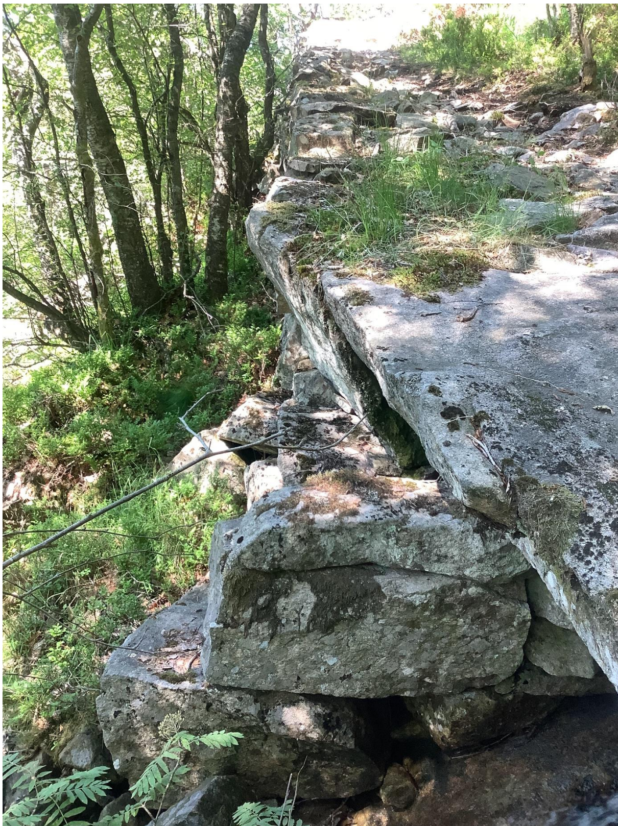
Figur 8. 32W Ø373230 N6453391. Den oppmurte veien på tur opp fra Svindal til Skarpheia er i partier fint utført, og med særlig ei svært imponerende helle brukt som bro over en bekk. Veien bør vedlikeholdes som en del av det helhetlige kulturlandskapet på Skarpheia, og sees i sammenheng med kulturlandskapet på Svindal. Foto. Solfrid Helene Lien Langmo.
