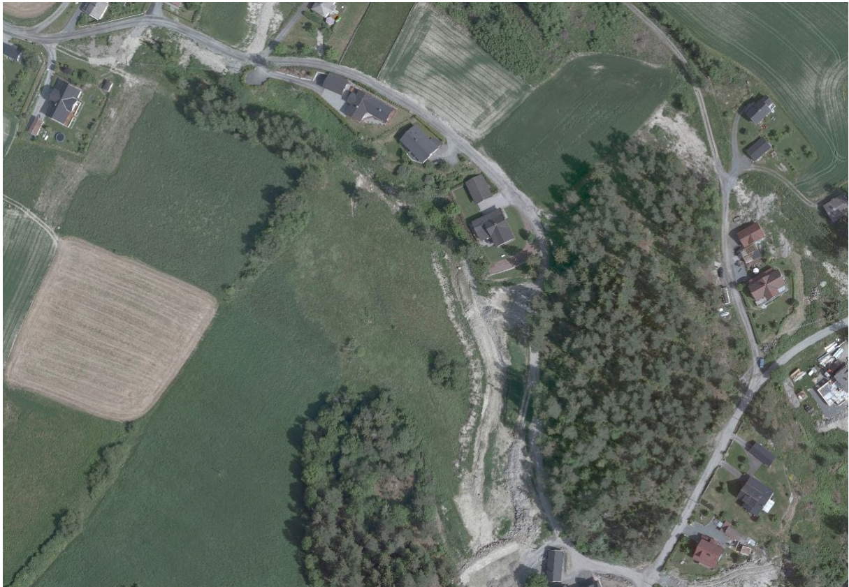
Figur 6. Flyfoto fra 2009 viser at det er utført et betydelig gravearbeid i området.
