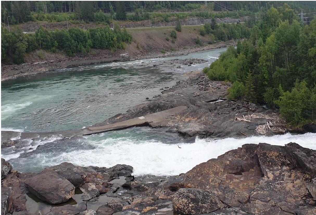
Figur 3. Kantsonene langs vassdrag i Norge er i mange tilfeller betydelig påvirket av ulike tiltak. Vassdragsreguleringer kan sterkt påvirke vannstand over og nedenfor demninger og skaper vandringshindre for fisk. Store veier inntil elver spiser av kantsonene og langs kraftgater ryddes skogen med jevne mellomrom. Forurensning og veisalt fra veier havner i elva. Lågen ved Hunderfossen. En stor-ørret som hopper kan skimtes i det den prøver å komme opp fossen nedenfor demningen. Foto: Ole J. Lønnve.
