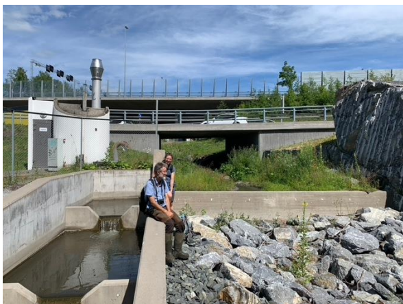
Figur 33: De siste par meter av Dælibekken renner gjennom fisketrappa ved lav vannstand som det var under befaringen i juli 2022. Foto: M. Bichsel, 2022.
