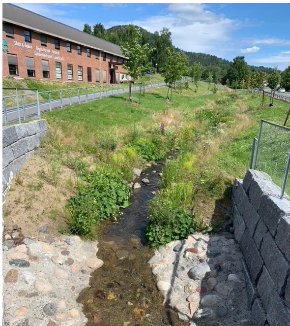
Figur 20: Oversikt over strekning B nedenfra opp. Foto: M. Bichsel, 2022.
