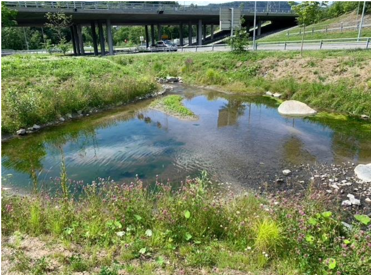
Figur 27: Dammen i strekning G er utsatt for mye næringstilførsel og høy lysinnstråling. Effekten av det blir synlig blant annet i oppkomst av alger. Foto: M. Bichsel, 2022.
