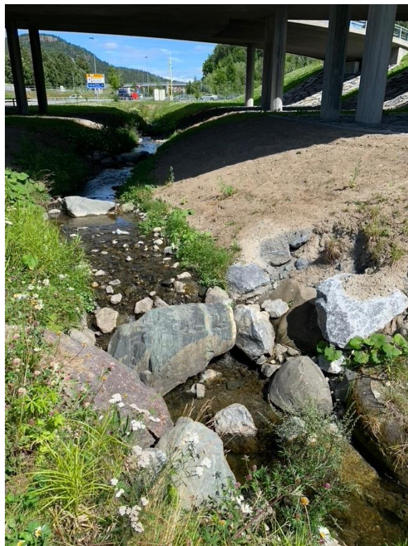
Figur 34: I strekning H renner Dælibekken under tre store bruer. En av utfordringene her er dårlig vekstvilkår under brua, hvor det er tørt og mørk. Foto: M. Bichsel, 2022.
