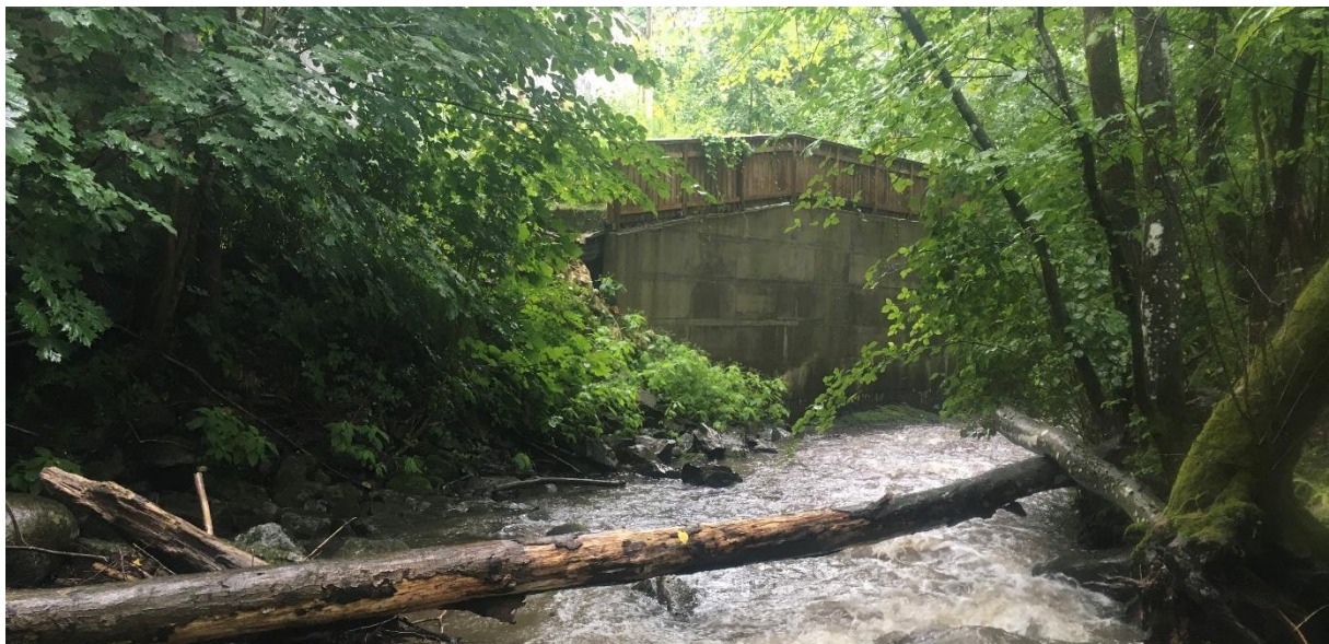
Figur 40. Betongkonstruksjon som går rett ut i elva (Ø39). Foto: Maria K. Hertzberg.
