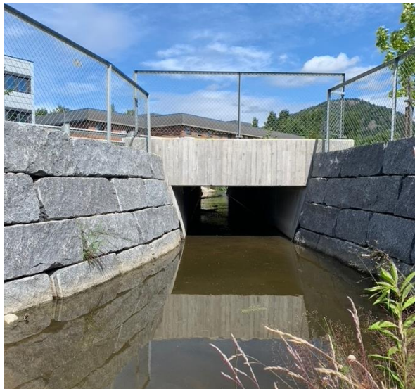
Figur 24: Strekning C. Vannmassene virker som å ha lite sirkulasjon nedenfor der Bærumsveien krysser Dælibekken. Foto: M. Bichsel, 2022.
