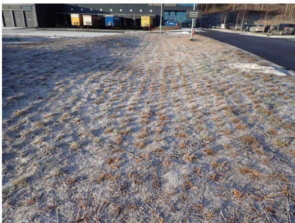
Figur 5: Eksisterende regnbed, nord i tiltaksområdet. Foto: K.M. Olsen, 2022.
