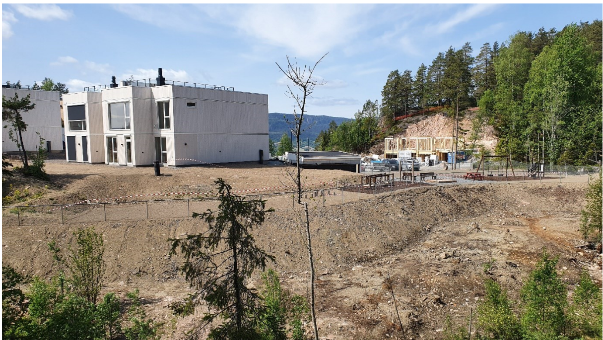
Figur 10. På grensen til planområdet ved eksisterende nybebyggelse er skogen hogd og bakken planert helt ned til bekken, se øvre bilde. På nedre bilde fås mer oversikt over hvor stort areal som har gått med for å sette opp ett bygg. All naturlig vegetasjon er fjernet helt ned til bekken.
