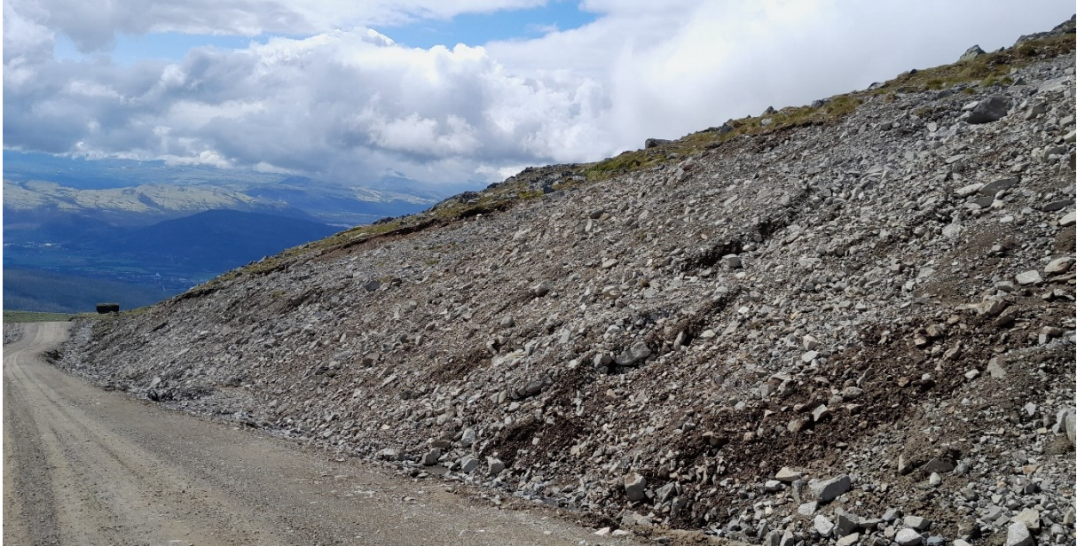
Figur 9. Høy veiskjæring i området som er foreslått som erstatningsområde.
