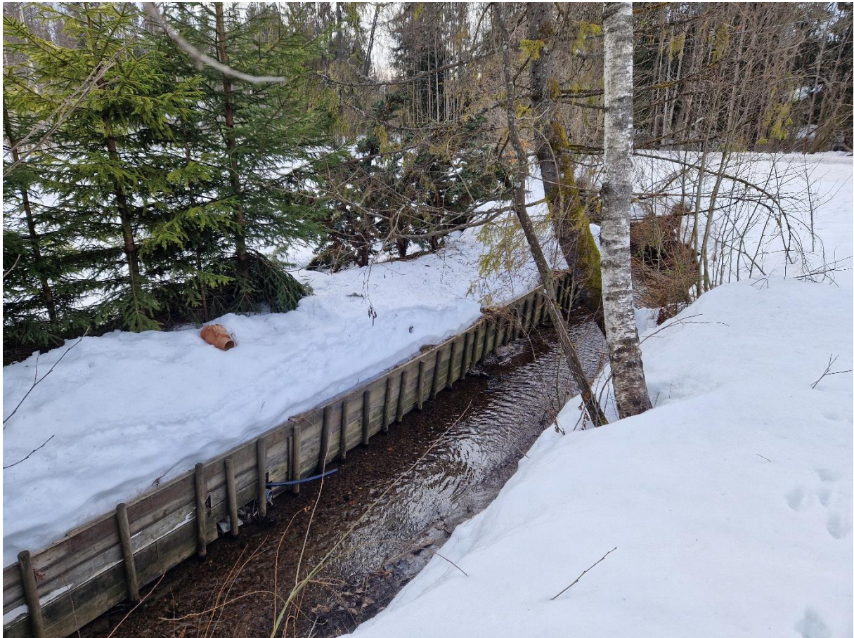
Figur 8 Smal kantsone til kanalisert bekk vest for planområdet.
