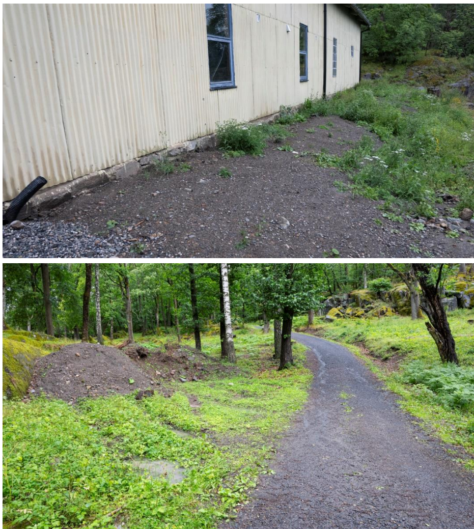
Figur 35. Øvre: Opppharving av engvegetasjon rett sør for verkstedhangar, som har ført til at halvparten av arealet mellom bygget og turveien ble åpen mark. Her spirer det nå mye vinterkarse og åkerugress, som må lukes. Nedre: utfylling av store hauger med masser i verdifull edelløvskog inntil turvei. Her spirer det mye vinterkarse og annet "ugress" nå som kan bli et fremtidig problem. Her er også et godt eksempel på hvor fremmede arter må lukes.
