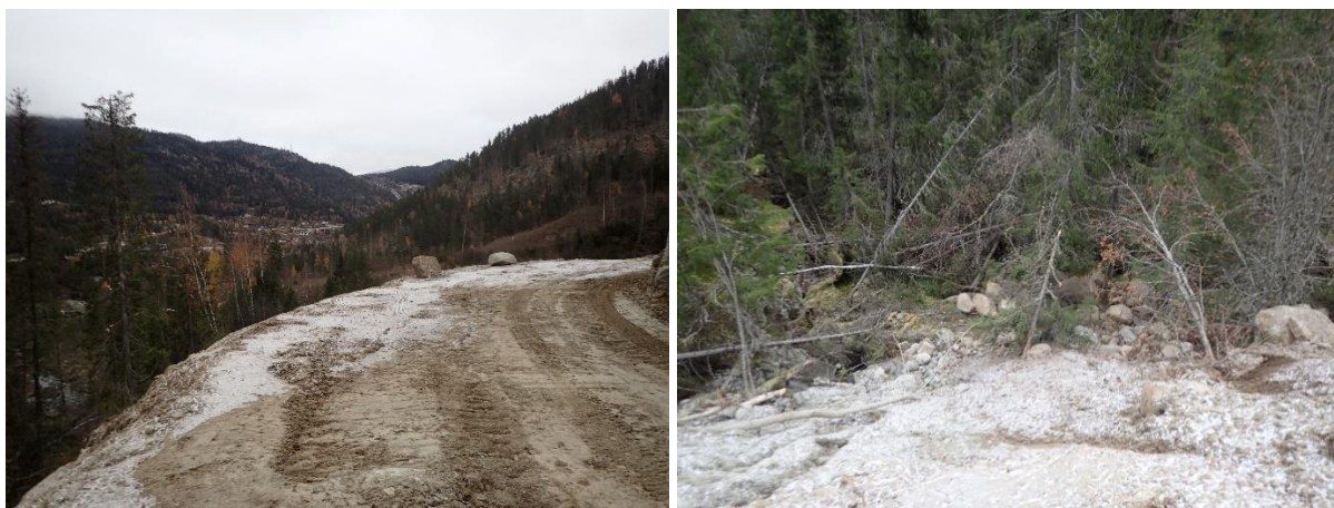
Ny og utvidet vei inn til planområdet anlagt høsten 2024, med fylling og løs stein inn i randsonen til eksisterende naturtype langs Uvdalsåi. Foto: Sigve Reiso.
