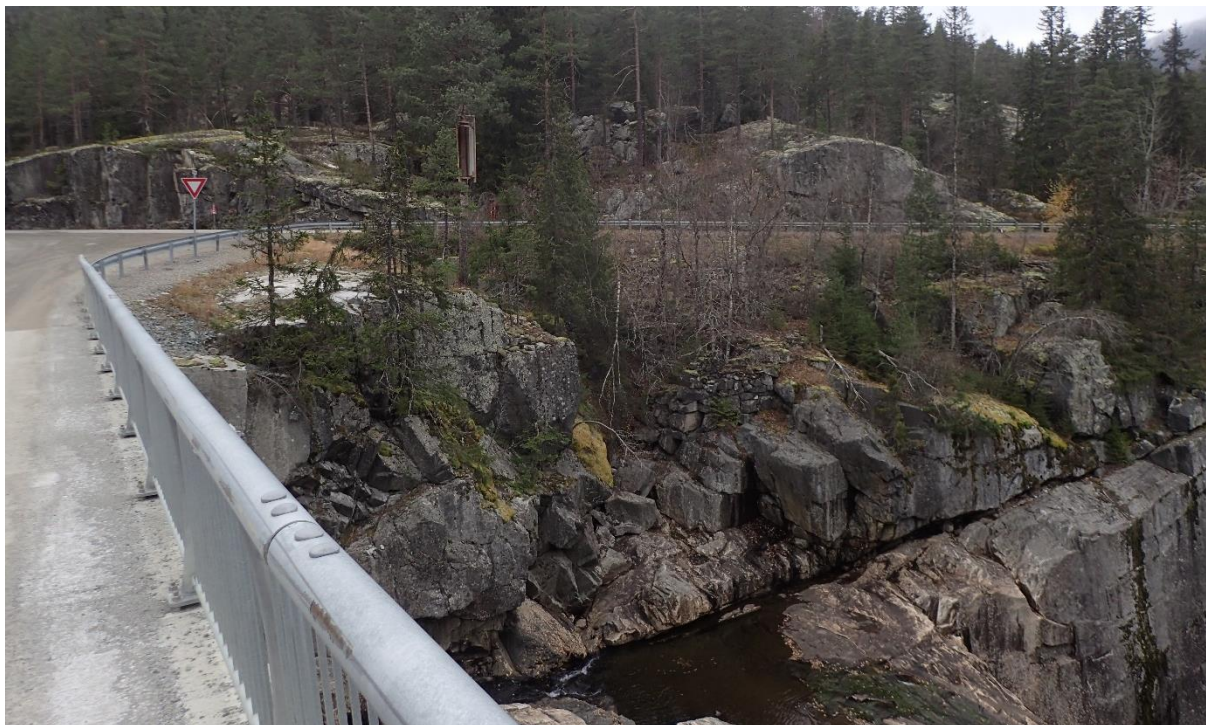
Det er planer om å utvide påkjøringsarealet mot hovedveien, det er i den sammenheng viktig å påse at ikke det raser masser på trær eller over bergvegger ned i kløfta. Foto: Sigve Reiso.
