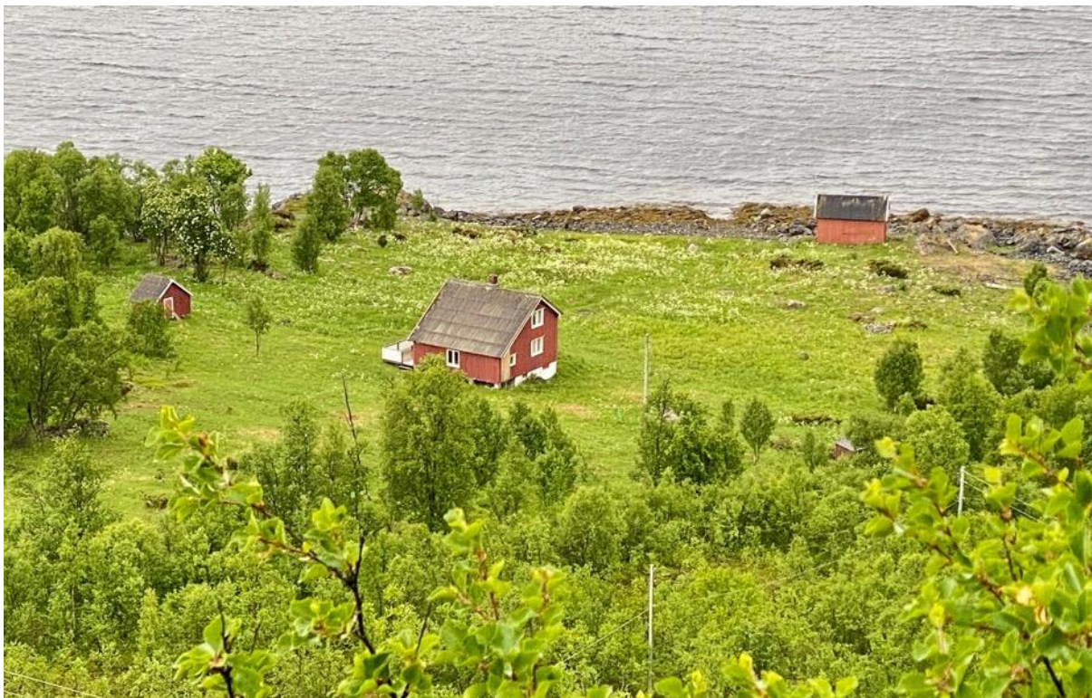
Figur 2: Våningshus, uthus, naust og utedo (til høyre for våningshuset i skogkanten). (P. Chr. Ellefsen, 2020)
