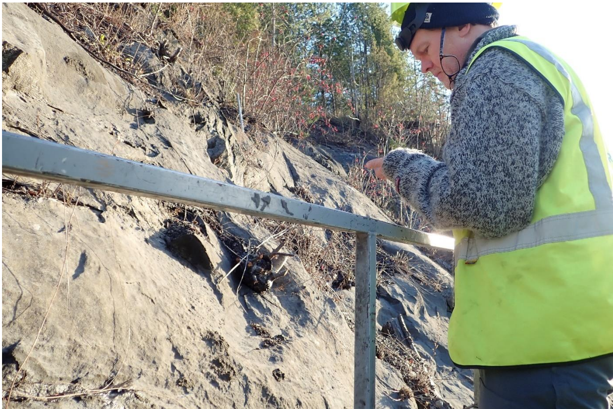
Arbeid fra lift i øvre deler av den vestvendte bergveggen. Foto: Alexander Nilsson.
