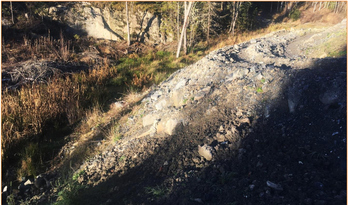
Figur 3. Søndre del av ravinen med fyllingen. Det er ikke fylt opp over bekken, hvor bekken og fuktdraget følger kanten av fyllingen.
