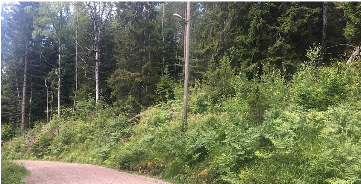
Figur 5. Gjengroing er et problem i flere av de artsrike veikantene. Her fra vestre del av Sleppa med einstape, løvkratt og gran som kommer opp.
