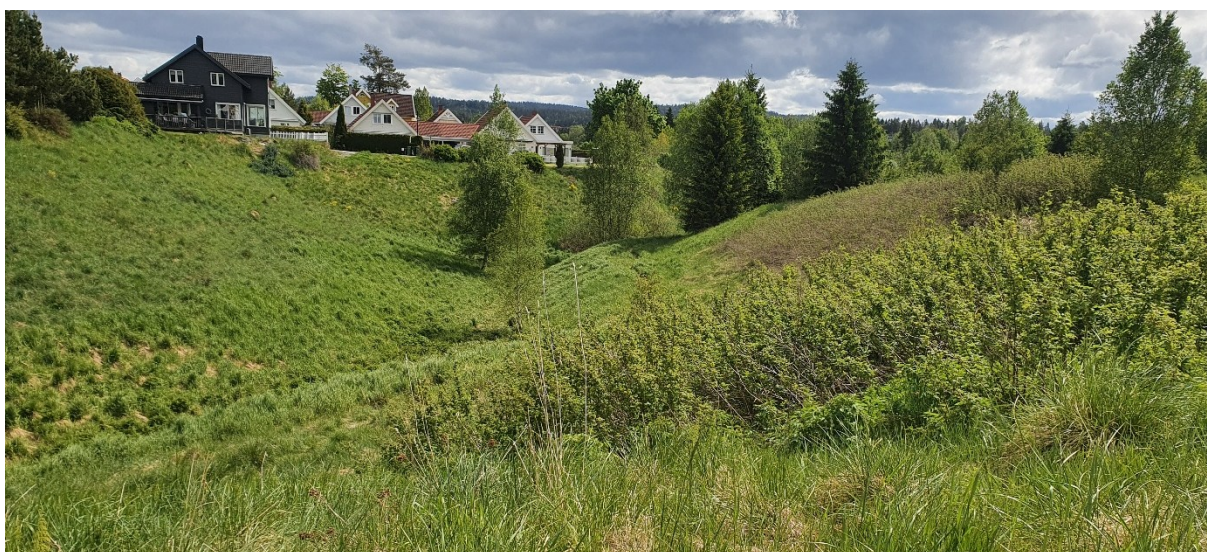
Figur 18. Bildet viser den nordøstre ravinearmen som delvis inkluderer naturtypelokalitet nr. 10. Det lille brekken i høydeprofilen i bunn av dalen skyldes nedgravd VA-ledning som følger bunn av ravinen, se bilde øverst til høyre hvor kummen er synlig. På tørre ravinerygger i lokalitet 10 er det urterike innslag med bl.a. svever og tiriltunge.
