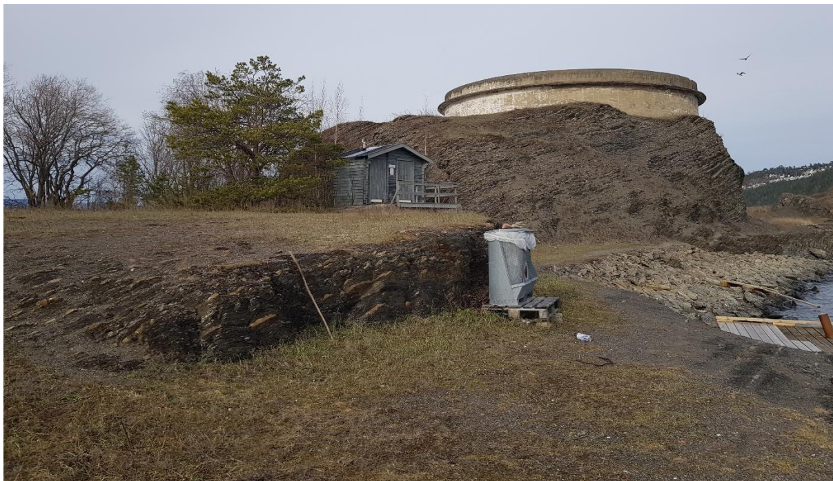
Figur 9. Sett mot øst. Toalett sees på bilde: 26.03.2025, Siri Khalsa.
